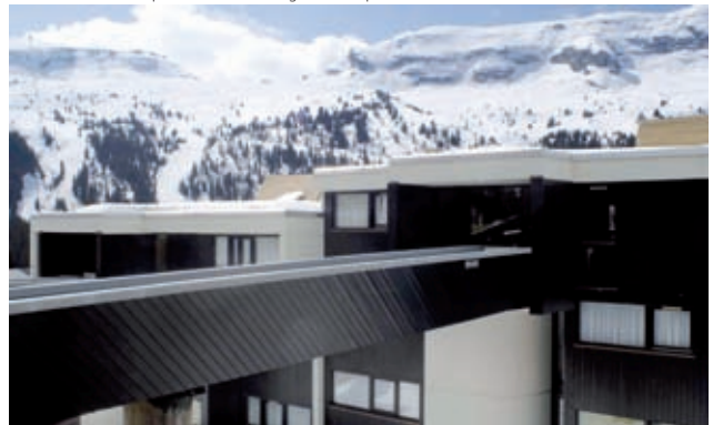
Immeuble Balance, passerelle et bardage en bois peint (R. Bianchi/CAUE 74)
