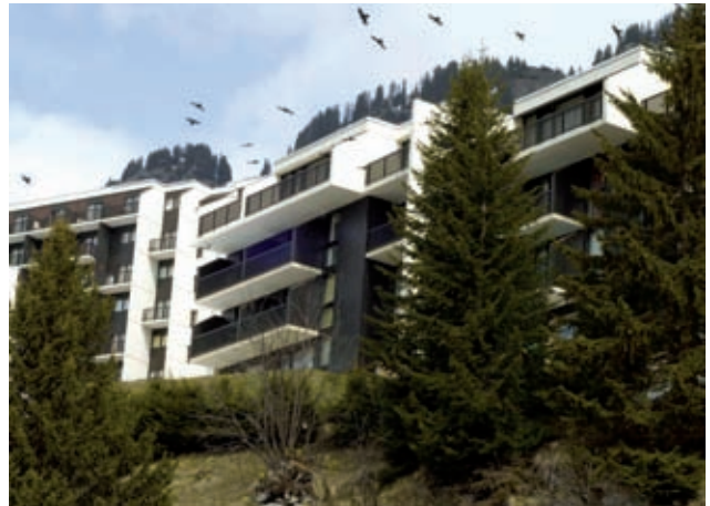
Façades rénovées à Flaine Forêt (R. Blanchi/CAUE 74)
