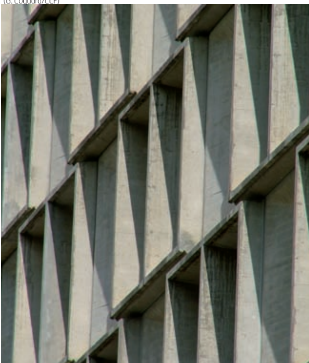
1, 2 & 3 : Hôtel Les Lindars, détails des fenêtres à caissons et panneaux en pointe de diamant. (G. Coquard/CCF)
