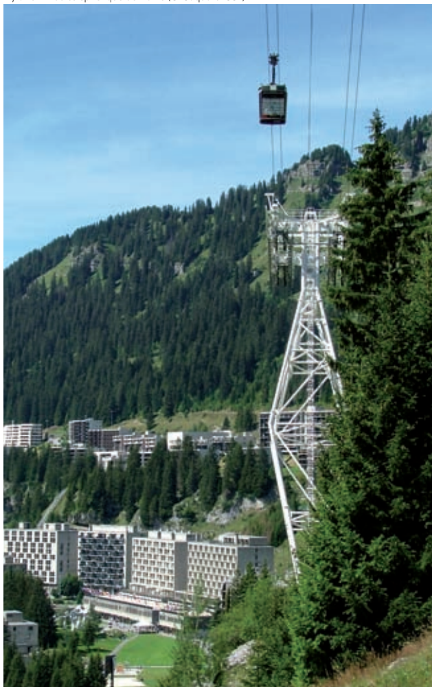
Pylone n°1 du téléphérique de Flaine (G. Coquard/CCF)
