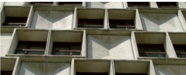
1, 2 & 3 : Hôtel Les Lindars, détails des fenêtres à caissons et panneaux en pointe de diamant. (G. Coquard/CCF)
